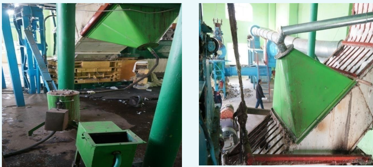
Рис.5. Монтаж увлажнителя волокна оборудования для увлажнения волокна
